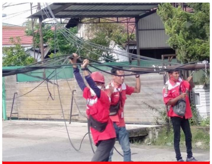
Caption : Teknisi lapangan Telkom lakukan perbaikan jaringan kabel induk yang rusak dihantam trailer pada Kamis (16/12/2021).
